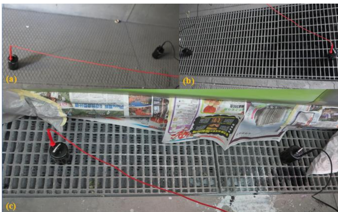
圖 8 烤漆爐地板電阻量測(a)鐵板地；(b)網溝地板；(c)網溝地板（作業中）
