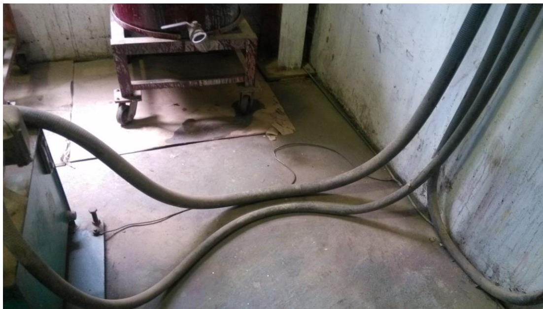
圖 16 調漆設備接地
