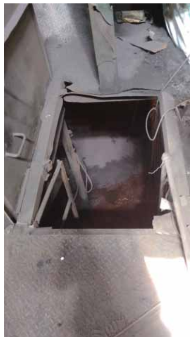
人員進入地下儲砂坑進行清理
